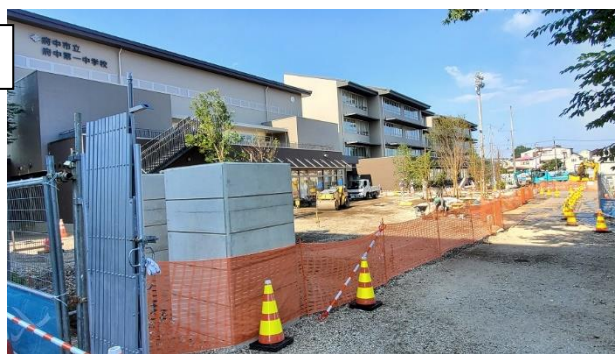
工事中の正門付近
