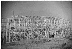
s30_第一校舎棟上げ式#6E0C7B.jpg
