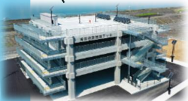
桑名市津波避難誘導デッキ
